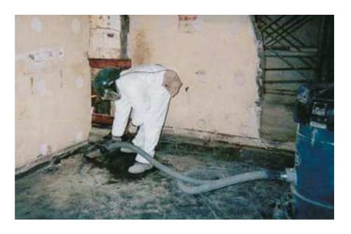
Un aspirateur avec filtre à très haute efficacité est un aspirateur industriel dont le filtre permet de retenir 99,99 % des particules.
