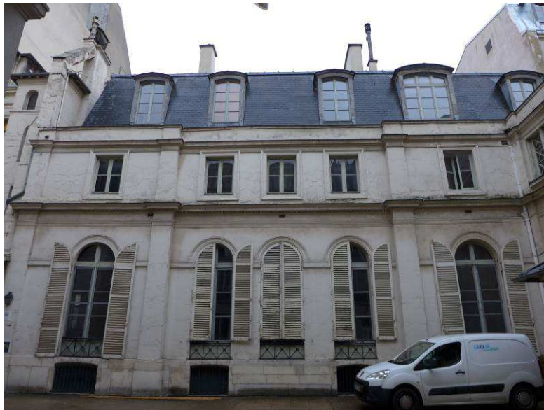
Hôtel de Bourrienne façade sur cour principale
