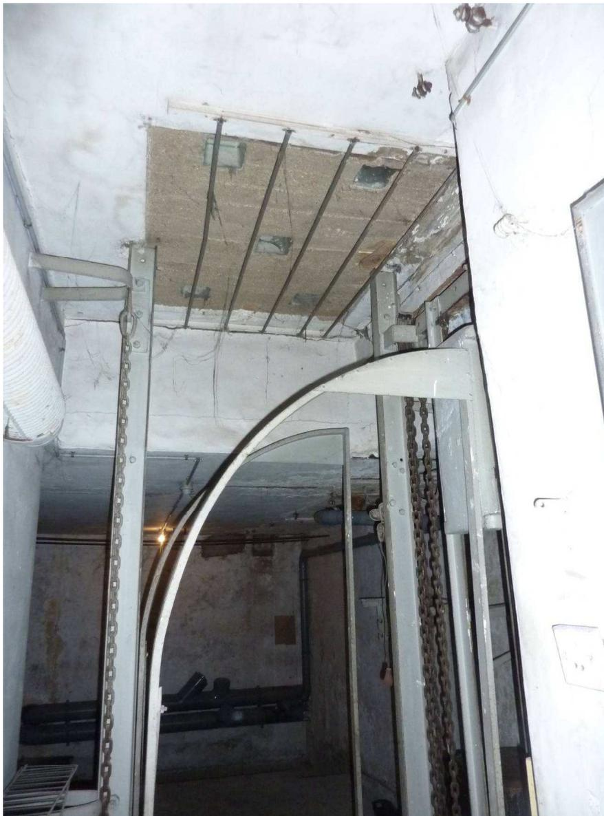
Figure 29 - SS - pavés de verre à déposer et remplacer - photo BMi
