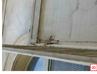
8 Dépose des persiennes et réfection de l'angle
