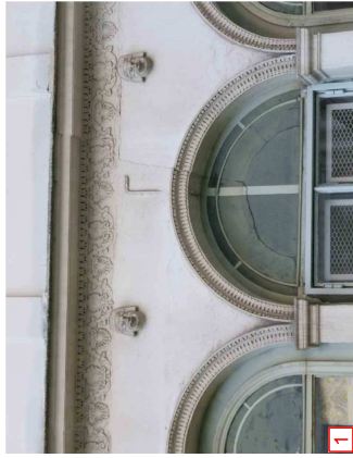
Dégagement des frises et des mascarons, réfection des enduits
