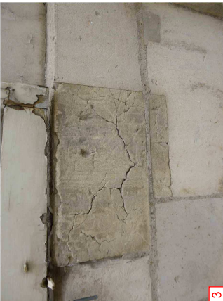
3 Remplacement des pierres du sousbassement
