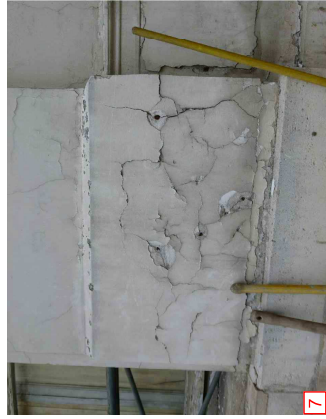
Piochage des enduits et remplacement des moellons si besoin
