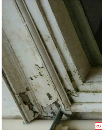
Piochage des enduits et remplacement des moellons si besoin
