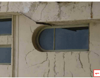
1 Réfection des enduits
