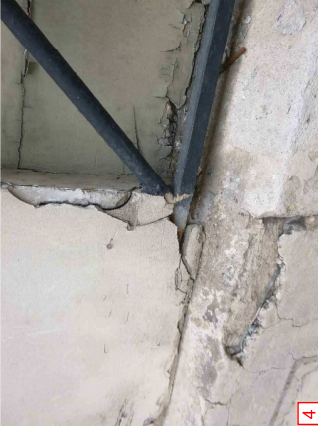
4 Dépose/repose du garde-corps
