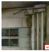
4 Dépose de la main courante de l'escalier sud
