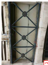
3 Révision des garde-corps en atelier
