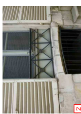
2 Révision des garde-corps en atelier
