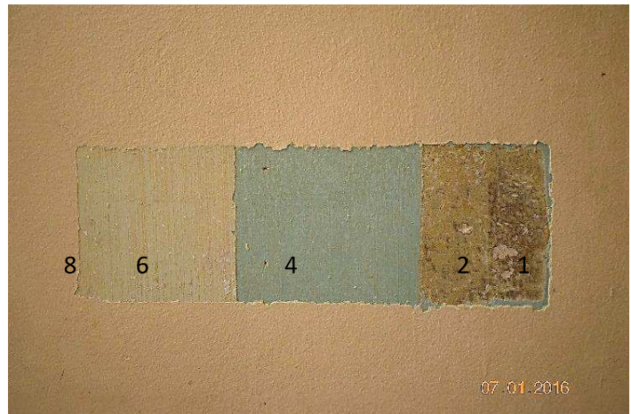
Vestibule – Vue rapprochée d'un sondage stratigraphique sur mur
