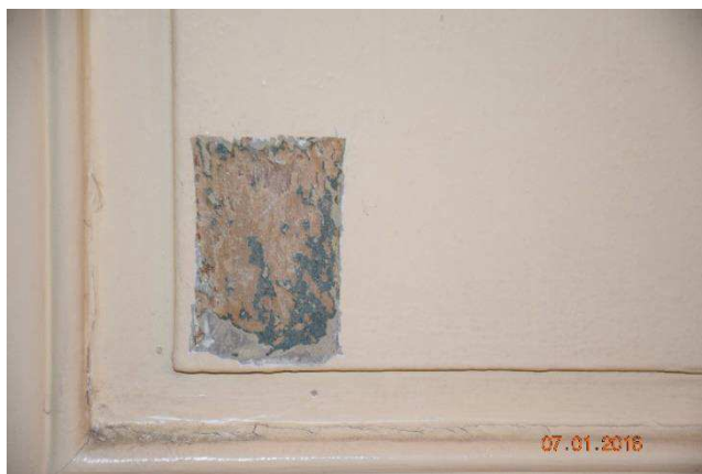
Vue rapprochée du sondage mettant en évidence la présence d'un décor de faux bois gratté et décapé avant repeints
