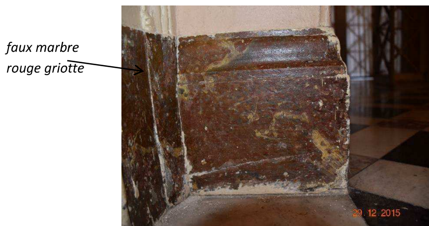
Vestibule -Vue rapprochée du sondage de la plinthe
