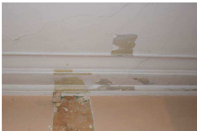
Vue d'ensemble des sondages effectués sur le plafond
