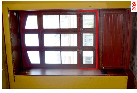
209 Restauration et réintégration des vitraux en partie basse
